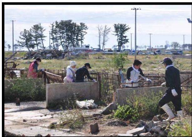
②現地作業リーダーの指示に従い、数名のチームに分かれて、瓦礫撤去を行いました。
