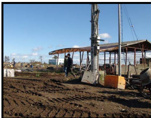
※作業が進み、土が見えてきました。
