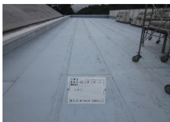
陸屋根部の防水工事 着手前
