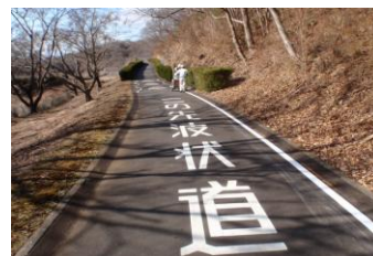
区画線工 施工
