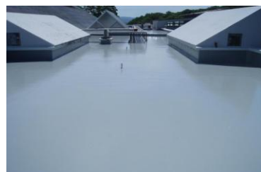
防水工事 完了
