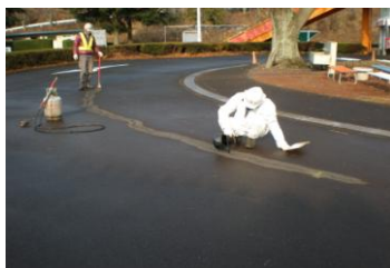
クラック補修 充填状況
