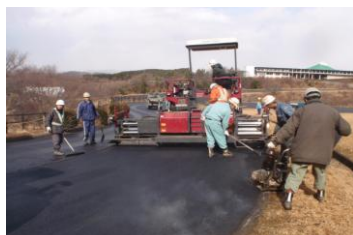
舗装工事 薄層工施工
