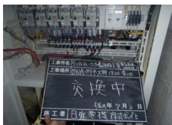
整流器交換・配線接続
