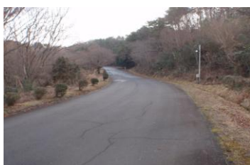
舗装工事 着手前
