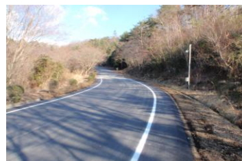
舗装工事 完成
