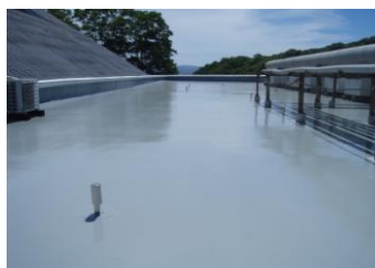
防水工事 完了
