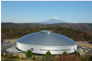
伊豆ベロドローム外観(南側全景)
