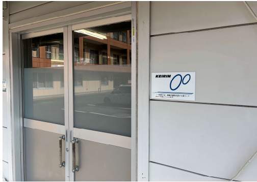
レーザー加工機・設置建物
