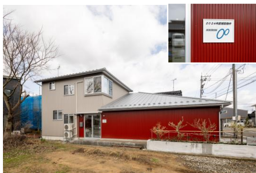
外観（側面）・玄関〔補助標識〕
