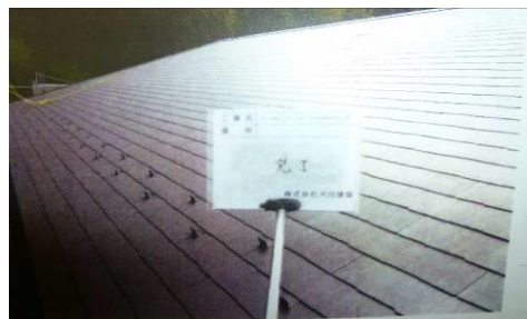
カバー工法により従前の屋根の上に
