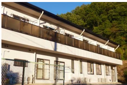
外壁塗装後の建物南側壁面
