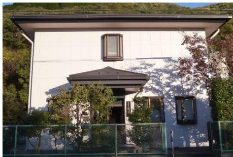
外壁塗装、カバー工法による屋根改修工事後の更生保護施設
