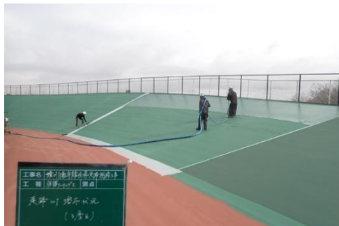
保護シーリング工
