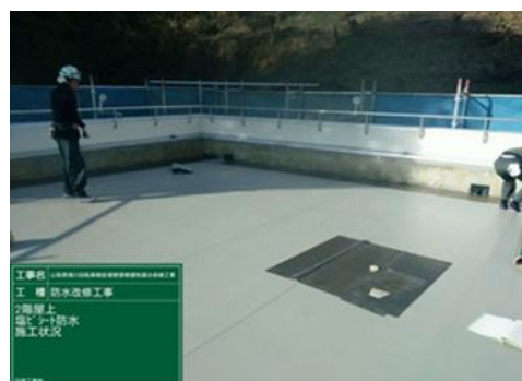
防水改修工事
