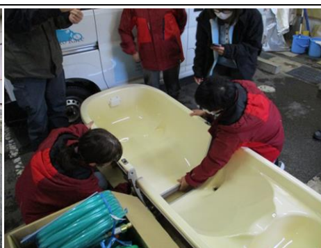
分割浴槽組立の様子
