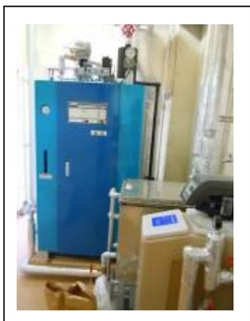
【入替後】新ボイラー（簡易蒸気ボイラー／SQ-800ZU） 2024年1月22日設置
