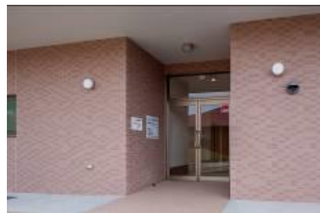
玄関（補助標識表示）
