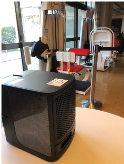
多目的ホール・食堂に設置
