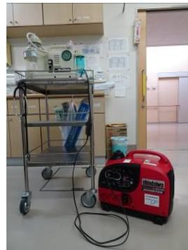
非常用発電機は停電時の酸素濃縮装置や痰吸引器等の電源として導入した。
