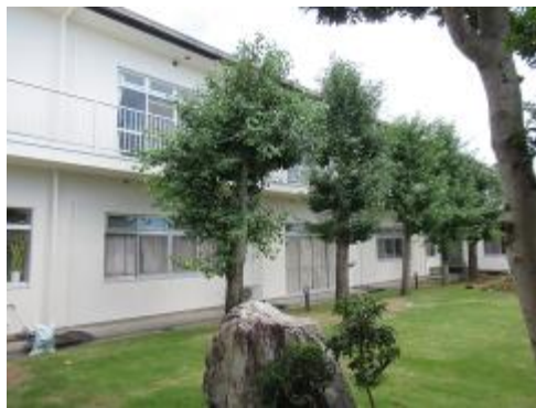
中庭側南面外壁
