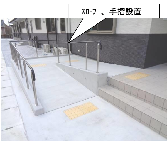
9 玄関へのスロープ
