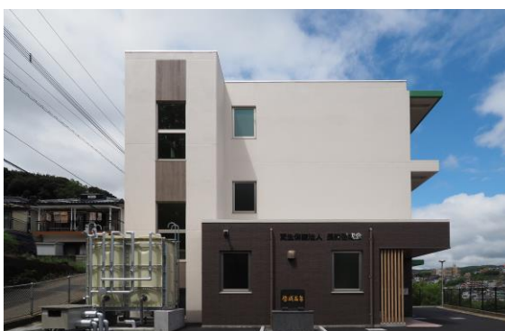
施設の外観（側面）
