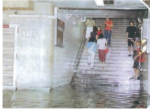
図 渋谷地下街の浸水状況(平成 11 年 8 月 29 日)
