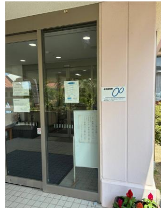
機器設置施設入口
