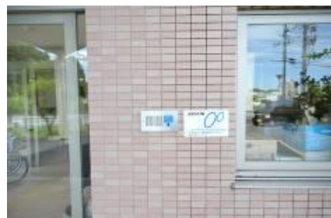
(機器を設置・使用している建物入り口付近の写真)
