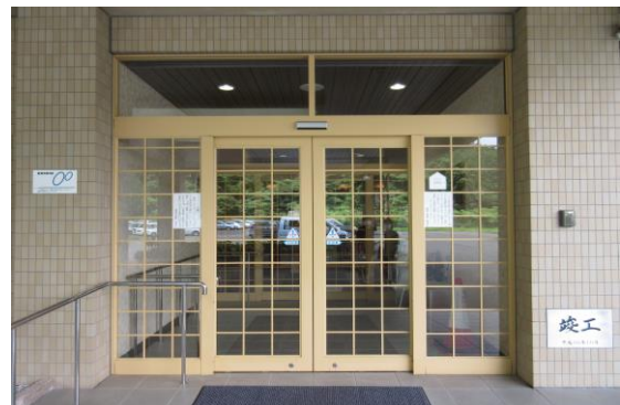
補助事業の標識を掲示した玄関
