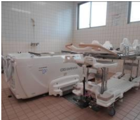
新館浴室 昇降式介護浴槽一式
