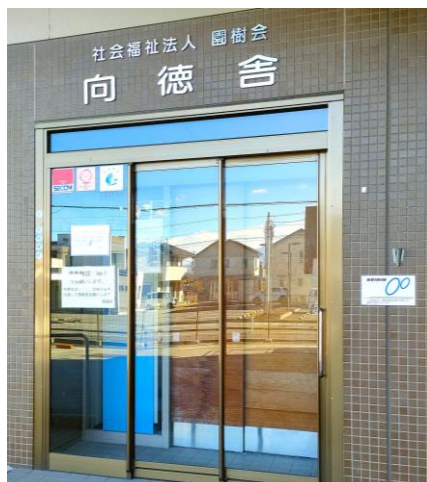
正面玄関 補助事業標識
