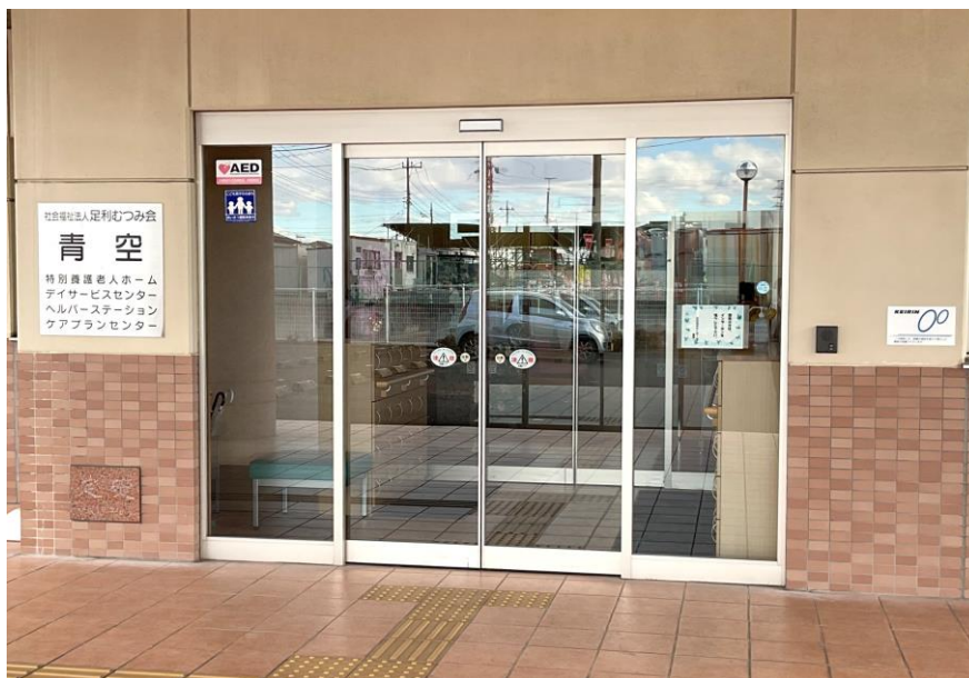
建物入り口付近 標識
