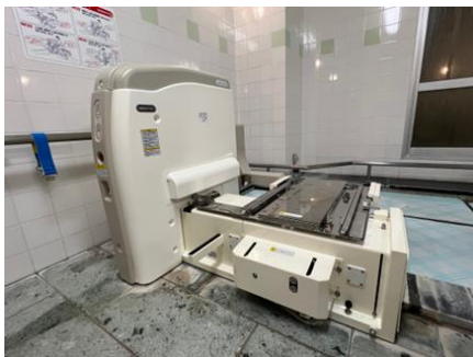
入浴装置（リフト）本体です。 2階一般浴槽へ設置しました。
