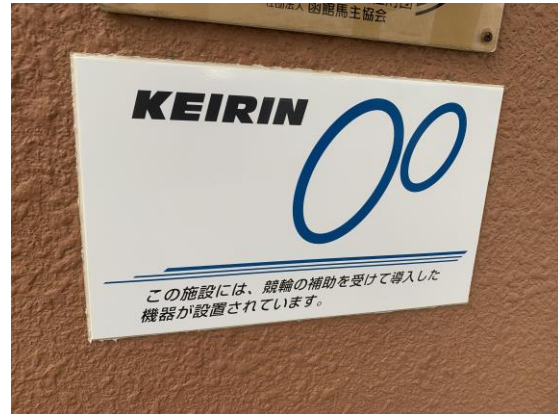
標識取付状況（拡大）
