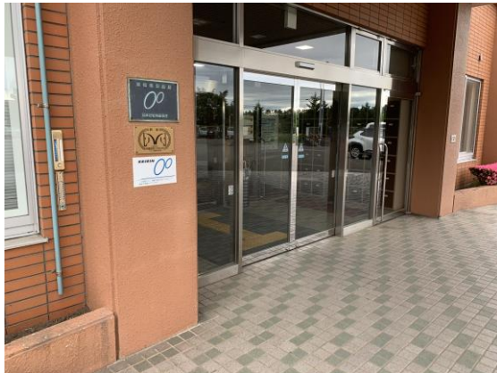
正面玄関標識取付状況
