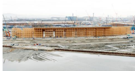
大阪灯台からの大阪・関西万博会場工事現 (令和 5 年 2 月 29 日)
