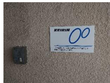
施設正面玄関横補助標識
