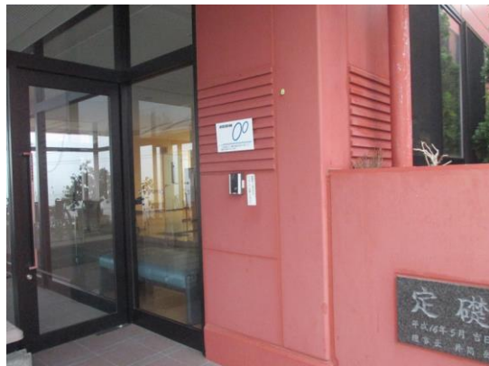
施設正面玄関の写真
