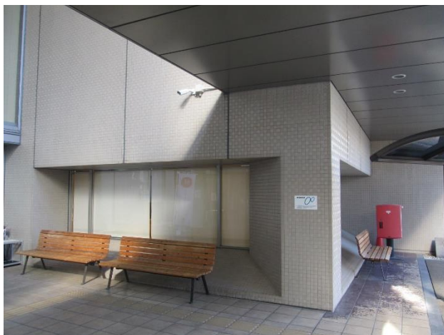
機器を設置した建物
