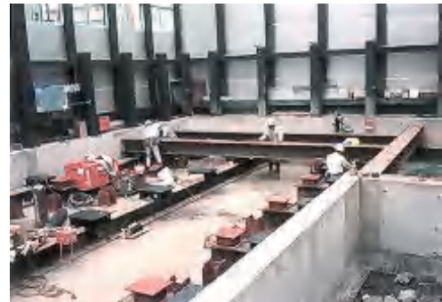
写真 5.2.2-6 防振装置による防振覆工
