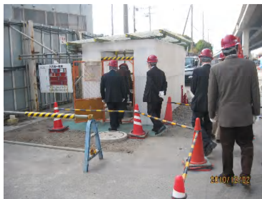
新磯子町第 1 立坑入り口付近
