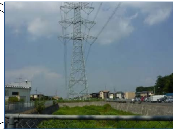
架空線敷設地域の事例
