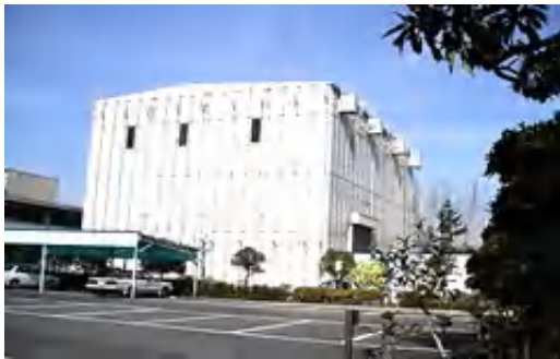
写真 5.2.2-1 防音ハウス例 1
