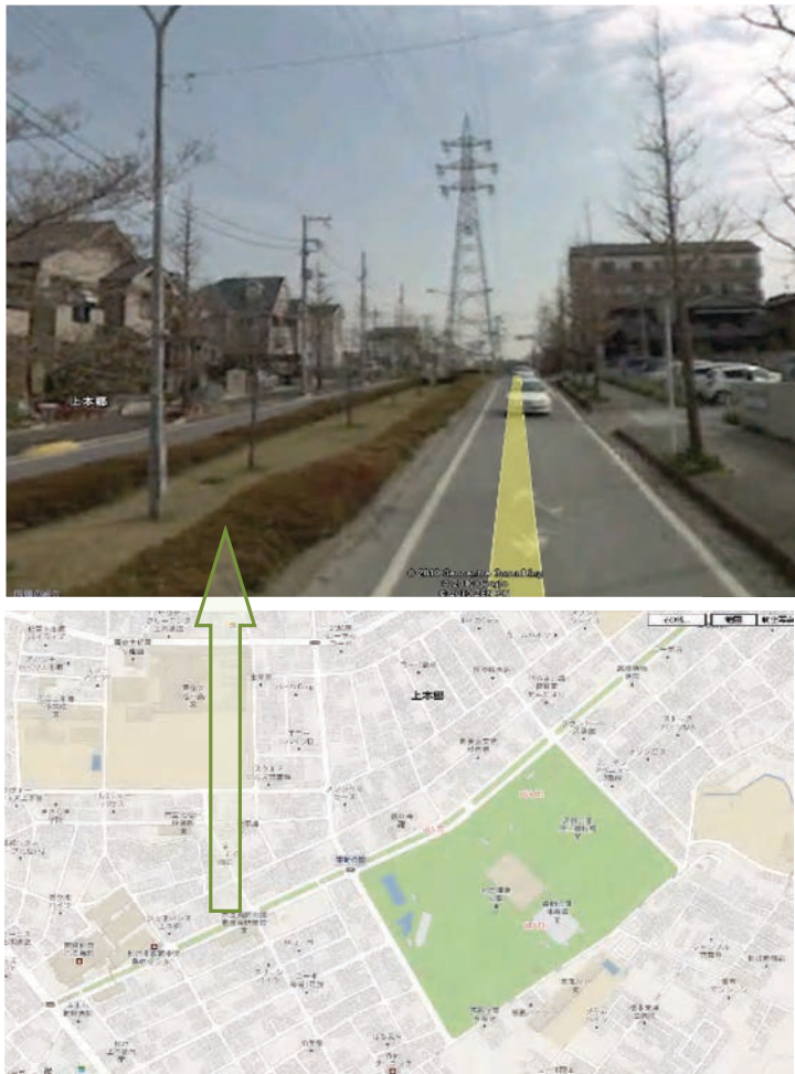
図 3.2-4 道路縦断方向 中央分離帯に架設された架空線の例（松戸市）
