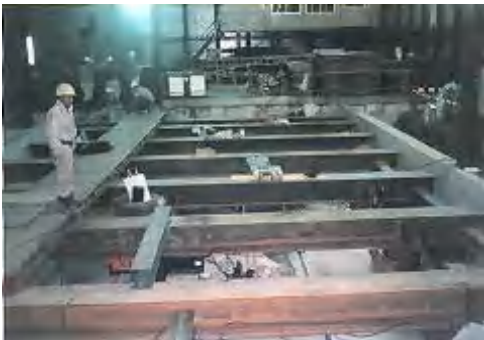
写真 5.2.2-6 防振装置による防振覆工
