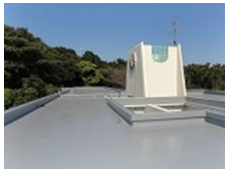
2F屋根防水（完成）
