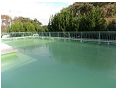
1F 屋根防水 (完成)
