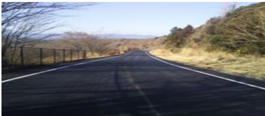
完了 (1.62km地点付近)
