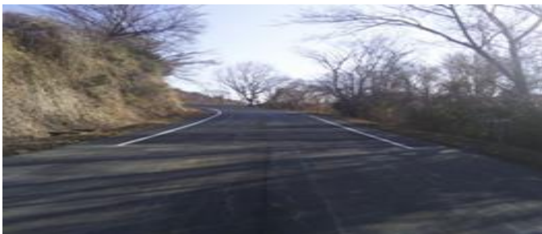
完了 (1.00 km地点付近)
