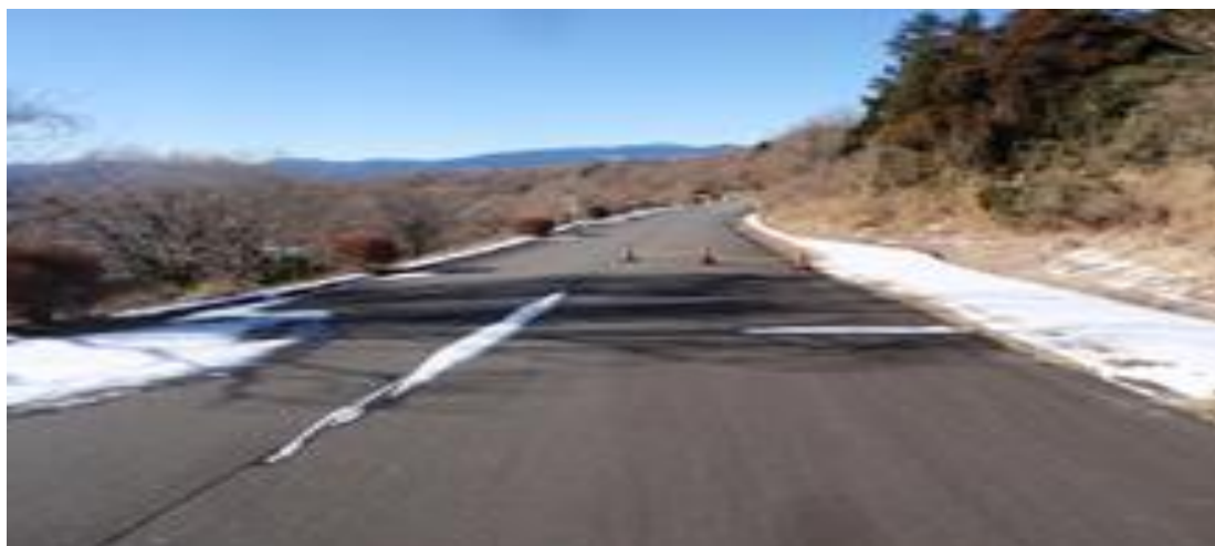
着手前③ (1.62 km地点付近)
