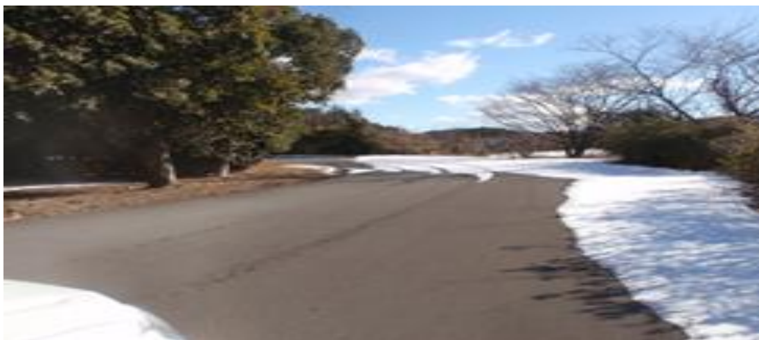
着工前② (中間地点付近)
