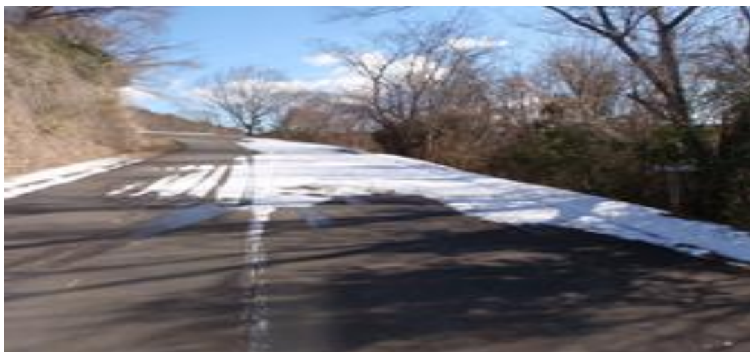
着工前① (1.00km地点付近)
