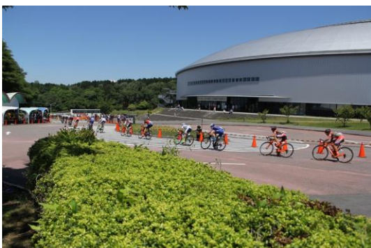
レース中の様子
