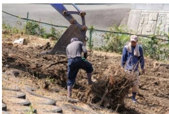
切り株撤去作業
