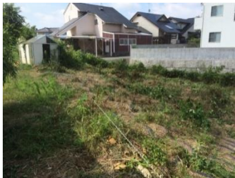
草木撤去作業
