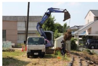
重機による作業
