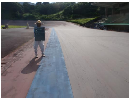
着工前 ホーム
