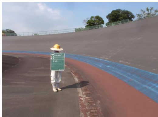
着工前 3コーナー付近
