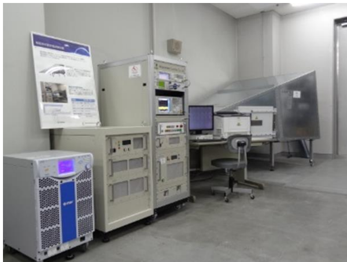
設置全体写真
