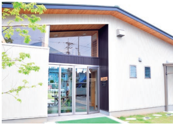
母子支援施設千代田寮の敷地内に完成した自立訓練棟「ひまわり」。
